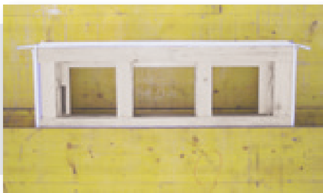
5. Pannellare e gettare avendo cura di non far cadere il calcestruzzo direttamente sopra il telaio. Disarmare i pannelli e staccare con attenzione i telai di sostegno: il lavoro è concluso.
