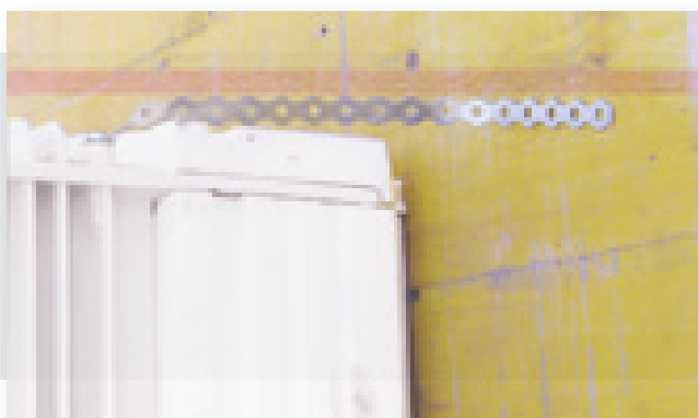
3. Elemento metallico per il fissaggio, posizionato nella parte superiore del telaio.
