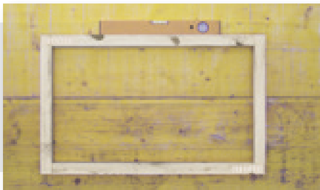
1. Posizionare al giusto livello il telaio premontato ed inchiodarlo al pannello.
